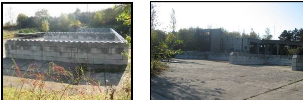
Aangepaste uitrusting op het overslagstation van Tienen
