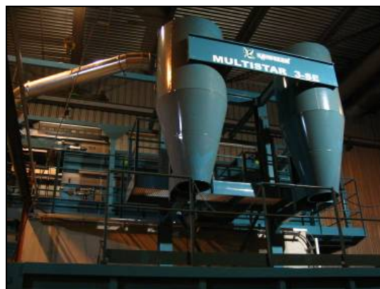
Foto 8: de nieuwe nabewerkingsinstallatie
